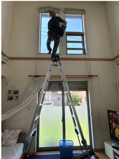
吹抜け住宅 高い位置の窓にも施工
