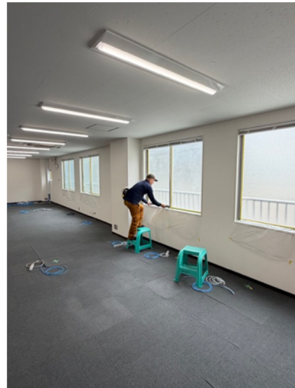
朝霞市 工場 窓が並ぶ大きな空間にも
