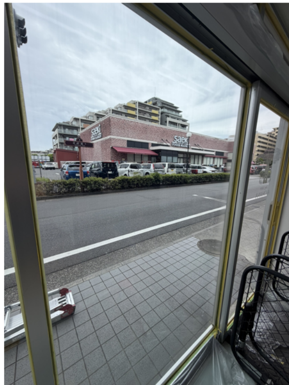
施工後も外の景色が見える
