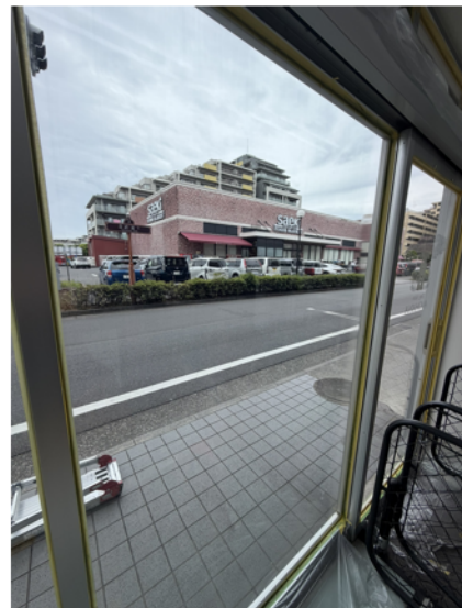
ペットサロン 景観を大きく変えずに施工
