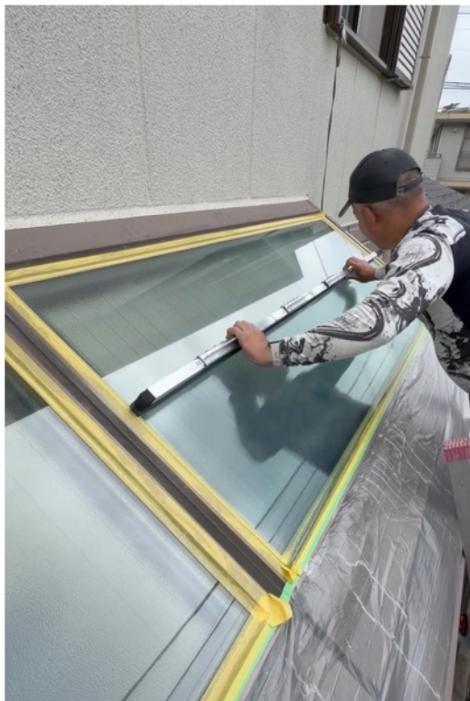
実際の施工風景
